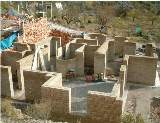
Imagen 3. Muros de carga monocapa en una vivienda unifamiliar aislada en construcción, Arquitecta Monika Brümmer, Andalucía.
