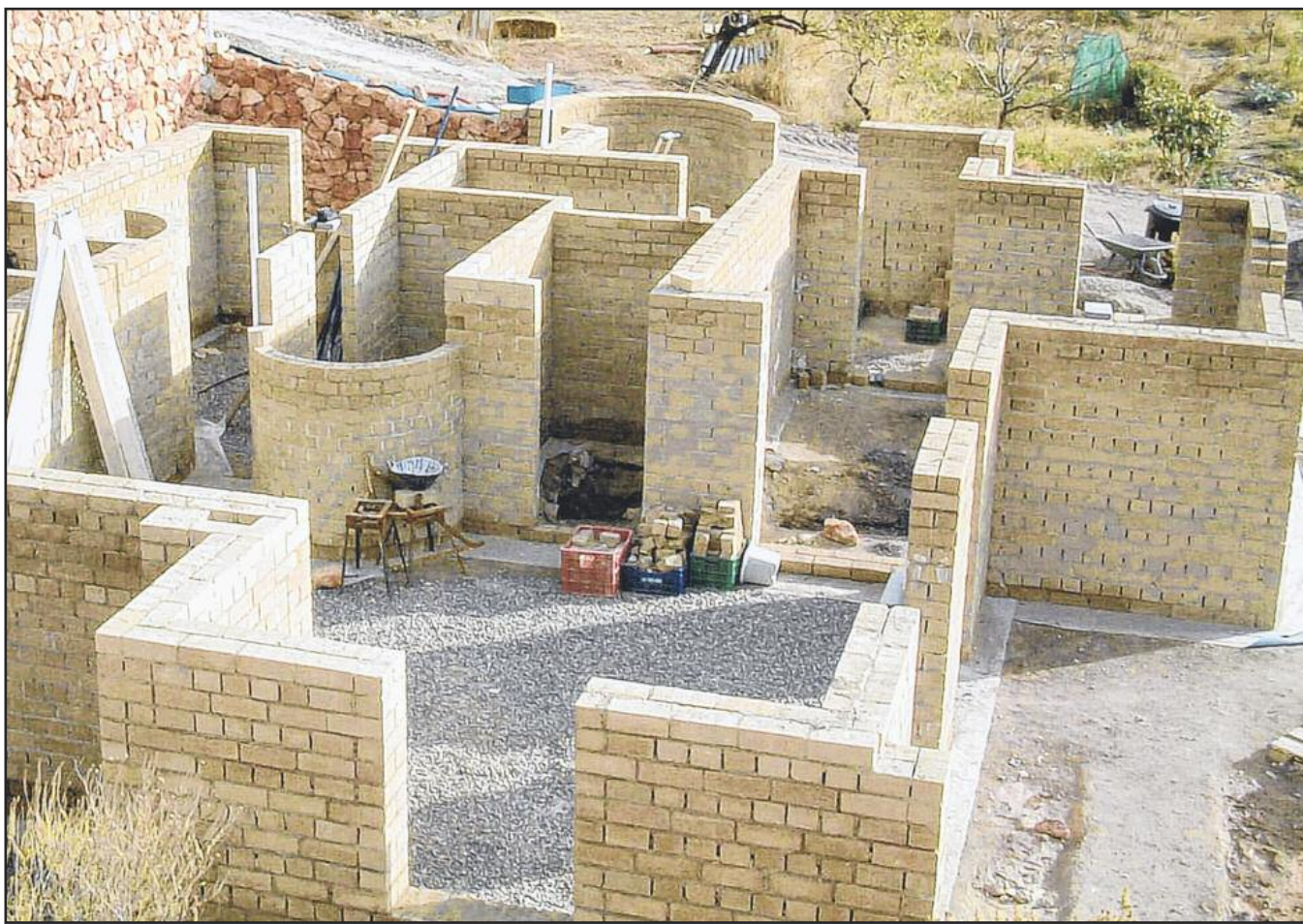
Cette construction dans le sud de l'Espagne fait usage de briques en chanvre développées par l'architecte Monika Brümmer. DR
